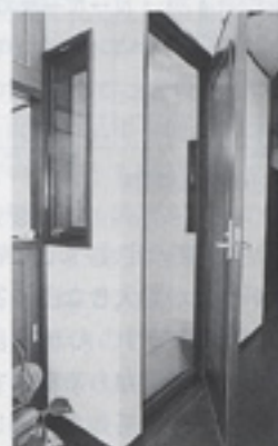
1階廊下から地下へ通じる、大建製木製防音ドアD-35型
