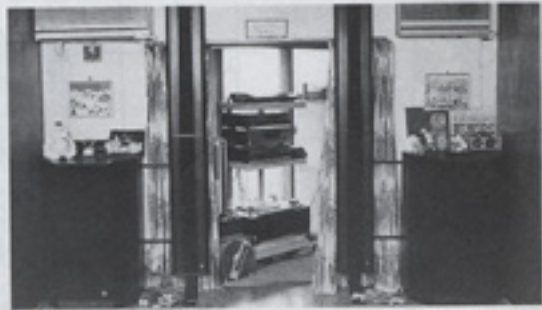
中央の開閉部は録音スタジオ増築以前は2重ガラスサッシの掃出しであった。現在はカーテンのみで、音楽聴取時は開放したままの方が音が良いという。前方左の壁面には壁掛け式エアコン、右壁面にはロスナイ換気扇が設置されている。マッキントッシュの特徴である24個のソフトドームトゥイターの背面はカーテンで見え難いが開口部にあたる
