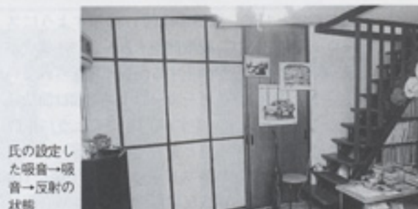
氏の設定した吸音→吸音→反射の状態に市販の吸音パネルGAC-600をセットしたところ
